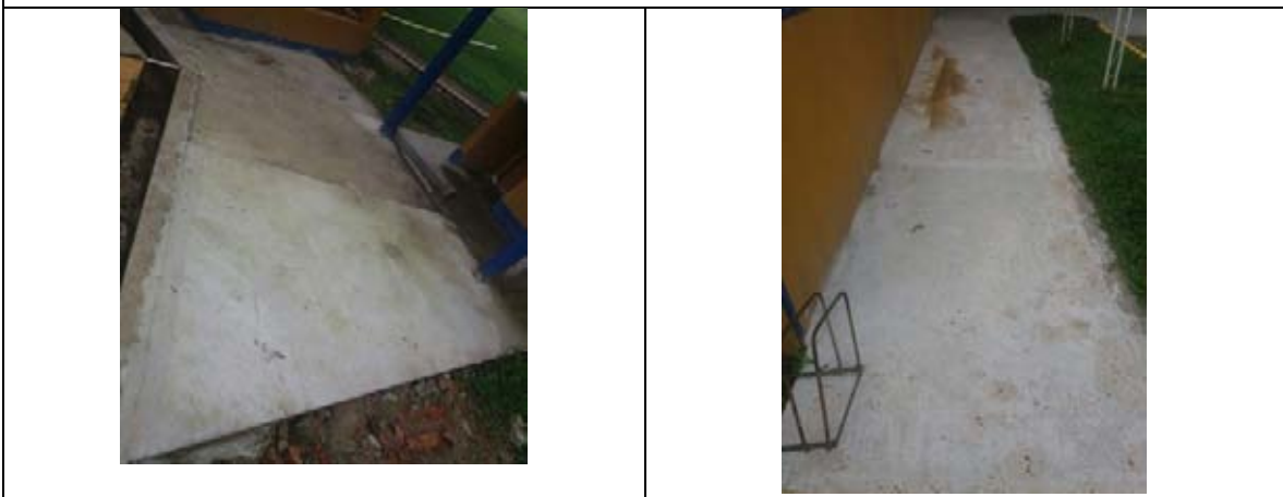
Remodelación de Andenes en zona del parqueadero, zona lavandería
